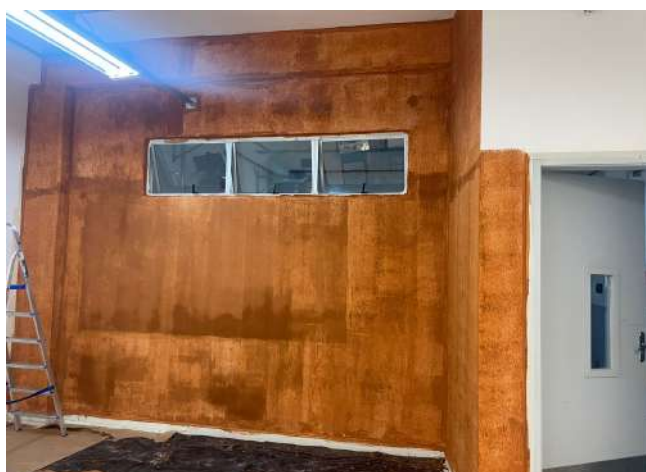
Figura 3: Parede após primeira demão de tinta
