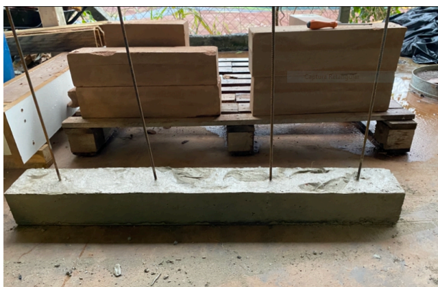
Figura 1: Preparação da base para elevação da parede
