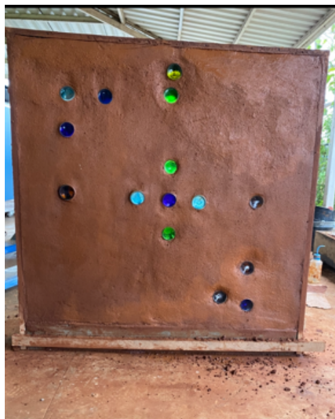
Figura 4: Finalização da execução da parede
