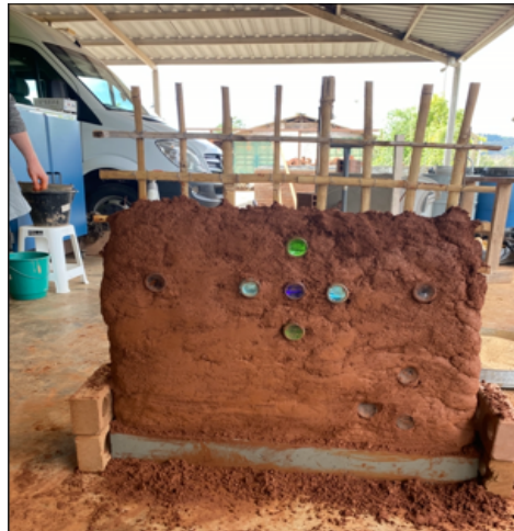
Figura 3: Inserção de garrafas na parede
