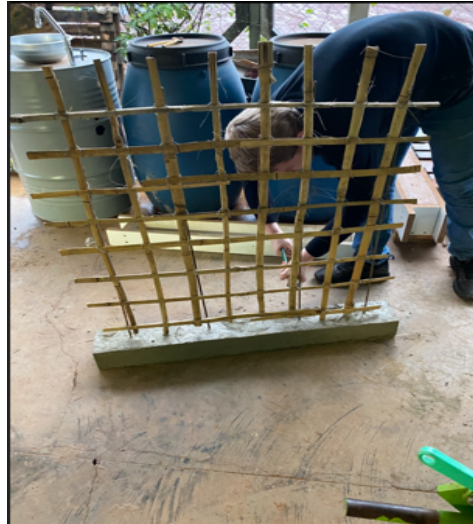
Figura 2: Execução da malha de bambu
