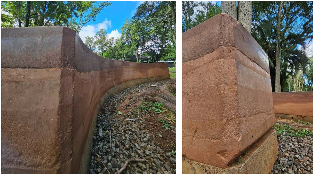
Figura 2 - Resultado final dos bancos em taipa de pilão após a aplicação da resina protetora.
