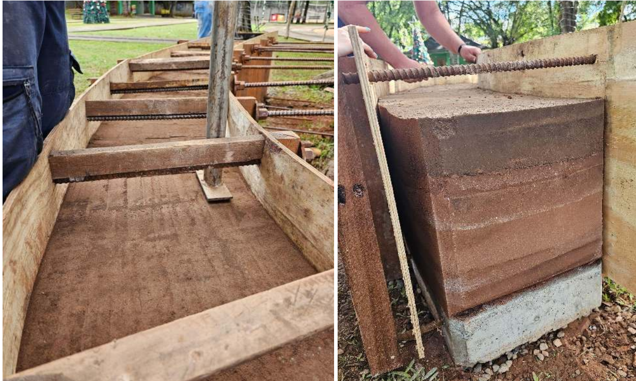
Figura 1 - Detalhe da última camada sendo compactada e da desforma do taipal após a finalização da compactação de todas as camadas.
