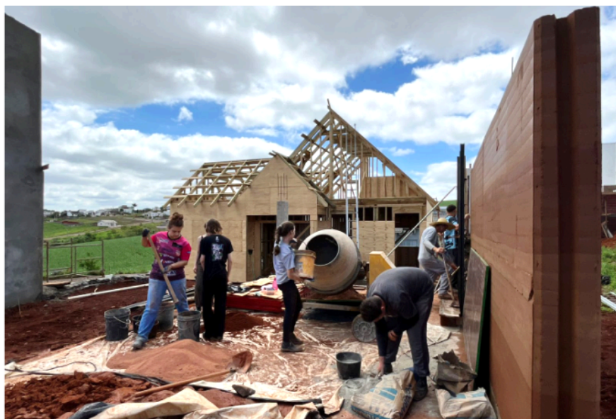
Figura 1 - Uma das paredes executadas com os alunos do terceiro ano de Edificações em visita técnica a construção.
