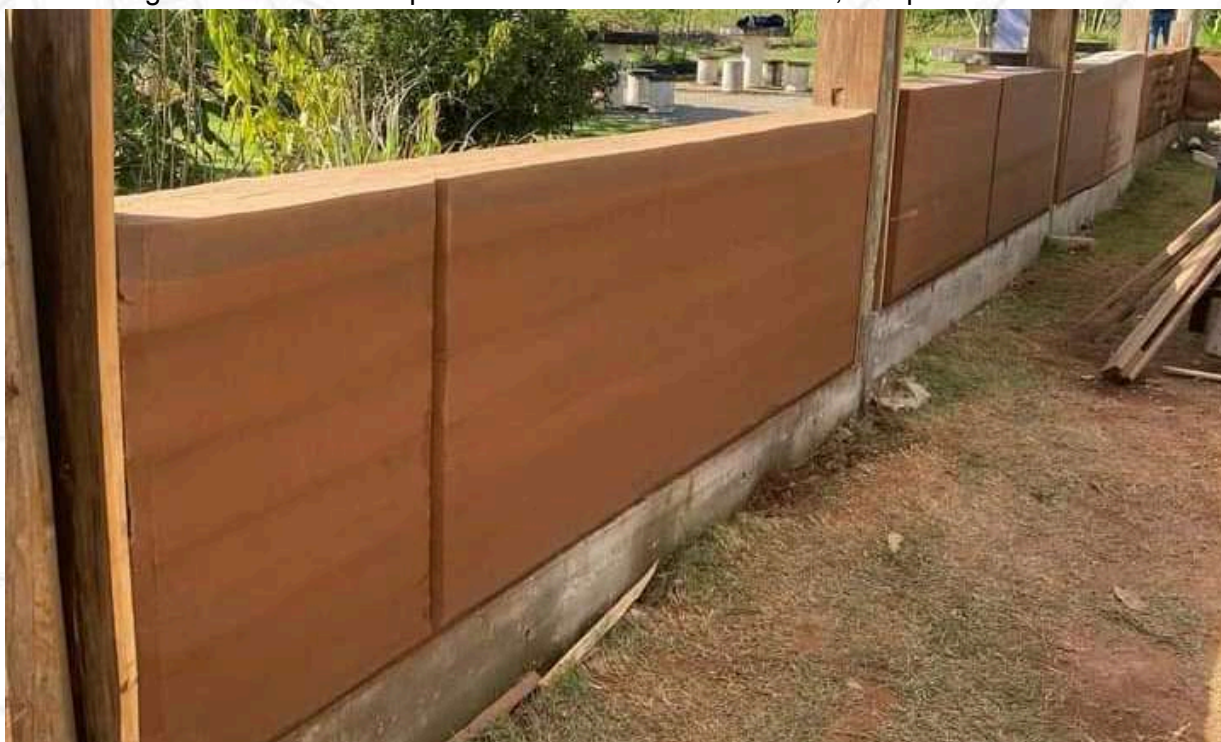
Figura 2 – Paredes experimentais executadas no IFSC, câmpus São Carlos.
