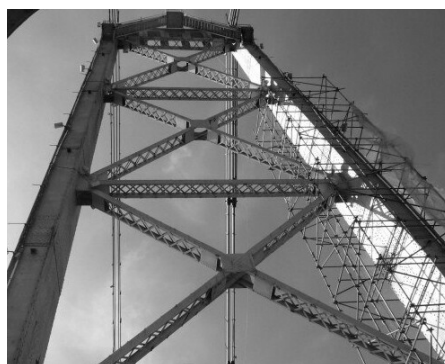
Figura 6 - Vista da torre principal FONTE: Hayashi, F. (2012)
