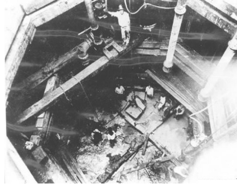
Figura 3 - Ensecadeira para a construção dos pilones de concreto no leito do canal
