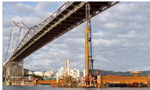
Figura 8 - Construção de estrutura provisória e para a obra de restauração e reabilitação FONTE: Santiago e Palaoro (2012)
